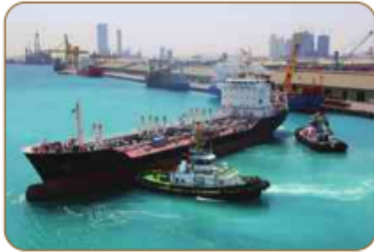
ميناء زايد لنقل البضائع
